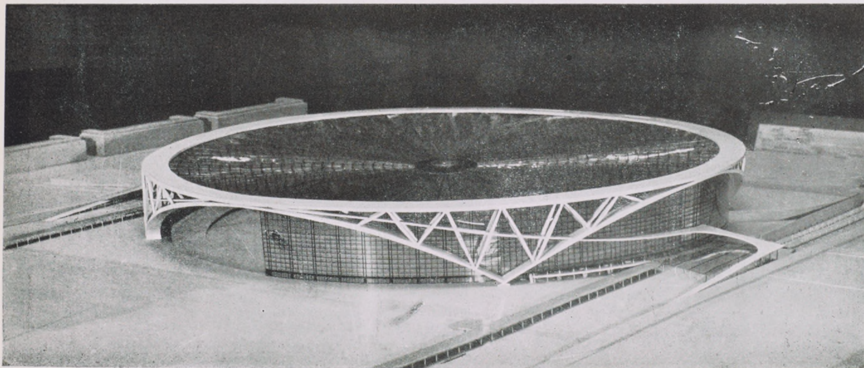
FIG. 16. Ce projet de Grand Palais fait à l'occasion d'un concours par les architectes P. Beaudouin et Lodge, comporte une couverture vitrée posée sur des câbles tendus. Le diamètre extérieur est de 400 m.
