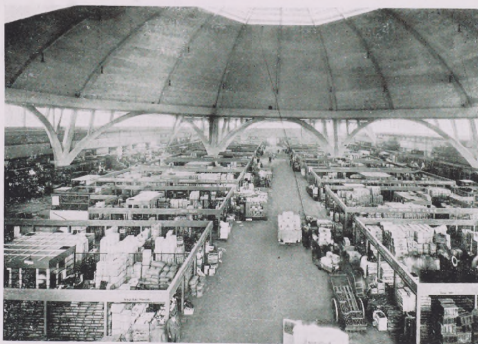
FIG. 27. - Les grandes coupes du marché couvert de Leipzig. Entreprises Dyckerhoff et Widmann. (Voir fig. 5, 5b et 5c).
