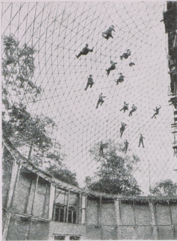
FIG. 7a et b. - Les légères coupôles Zeiss-Dynidag sont construites par projection au canon sur un coffrage mobile suspendu à une armature autostable.
