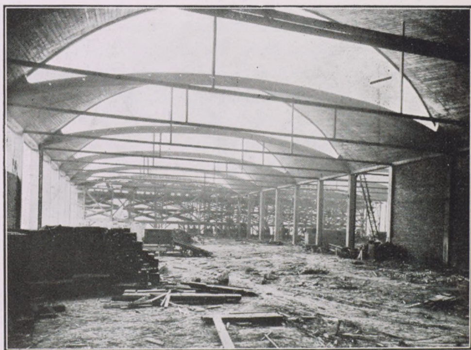
FIG. 11. - LES LÉGERES VOUTES CONOÏDES permettent un éclairage idéal des locaux industriels. (Cliché Génie Civil)
