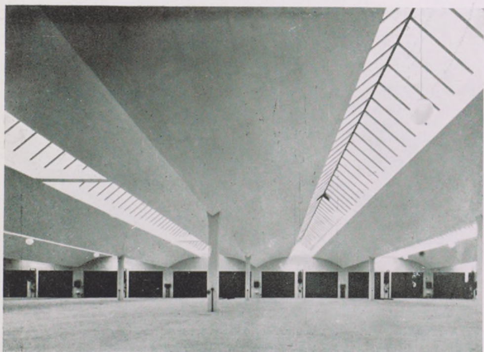
FIG. 10. - GARAGE DES POSTES DE NUREMBERG. Grâce au système des coques Zeiss-Dynidag on peut franchir des portées allant jusqu'à 40 m. (le voile n'a que 6 cm. d'épaisseur).
