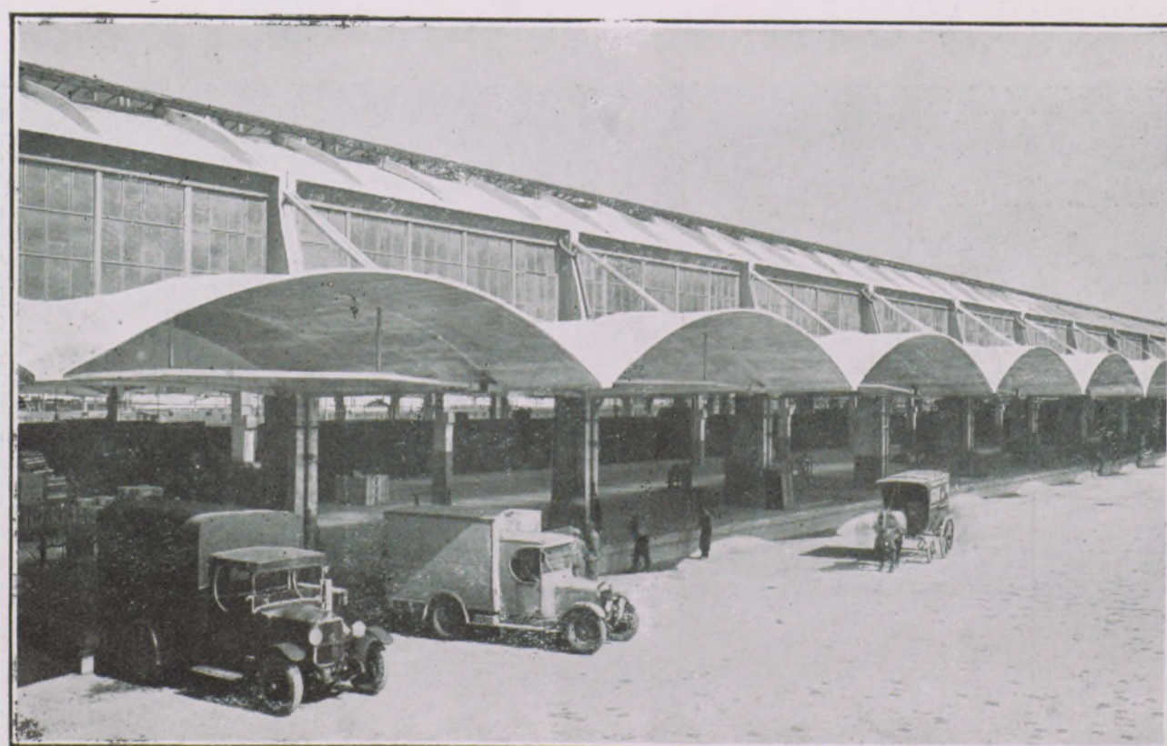
FIG. 12. - Les légers AUVENTS DE LA GARE DE MARCHANDISES D'AUSTERLITZ à Paris sont une application de la propriété raidissante des voûtes. (Cliché Génie Civil)
